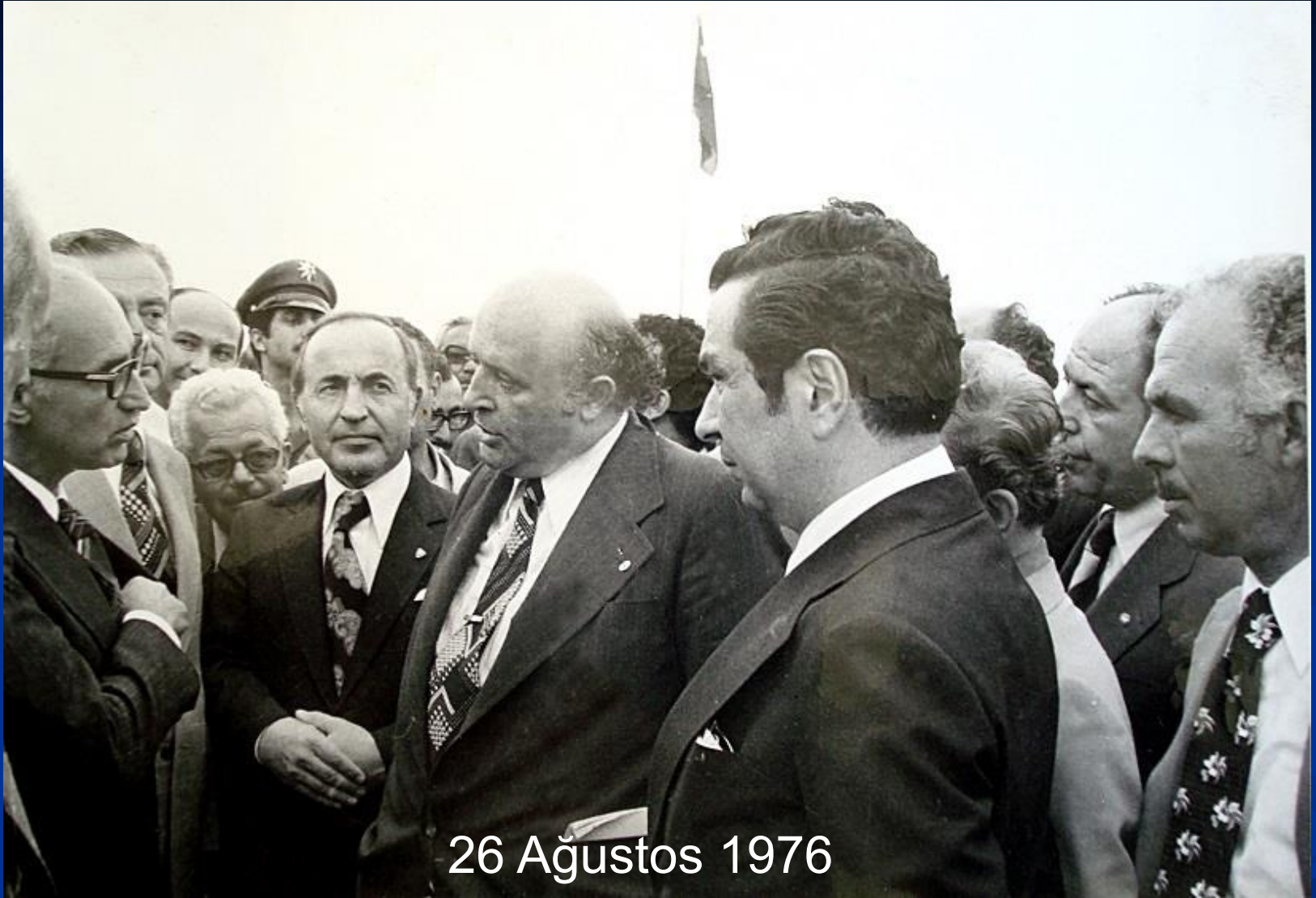
İ.Ü. Edirne Tıp Fakóltesi inşaatının Temel Atma Töreni
