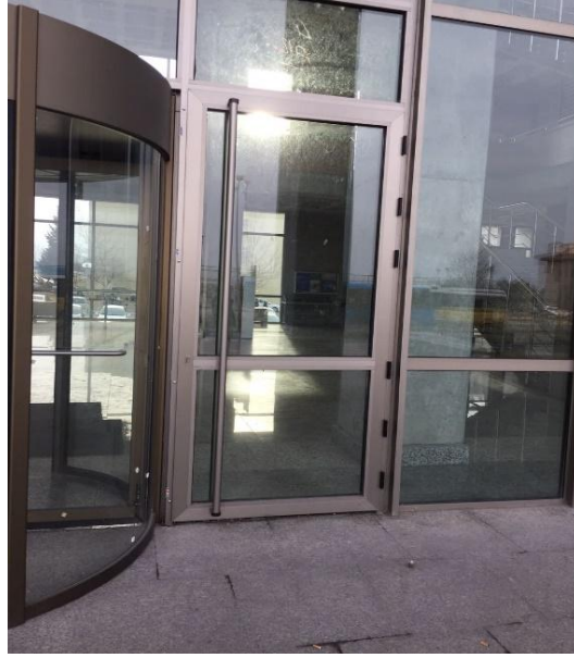
Resim GS.4.3.1/2: Dr. Ratip Kazancigil Derslik Binası'nın girişinde engellilerin kullanımı için tek kanatlı kapı.
